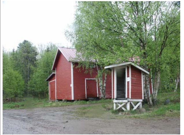
Kuva 8. Vanha maitolaituri tulisi säilyttää ja entisöitä, samoin kylällä olevat muut vanhat rakennukset.
