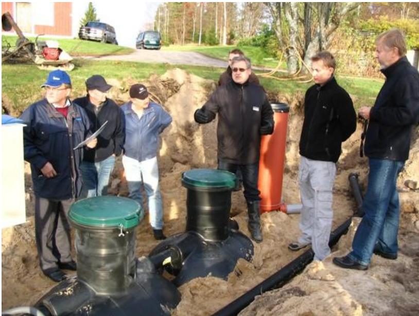
Kuva 4. Pienpuhdistamon asennusnäytös Sanginsuussa.
