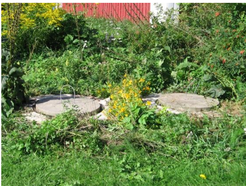
Kuva 1. Jätevesien pelkkä saostuskaivokäsittely ei enää jatkossa ole riittävä.
