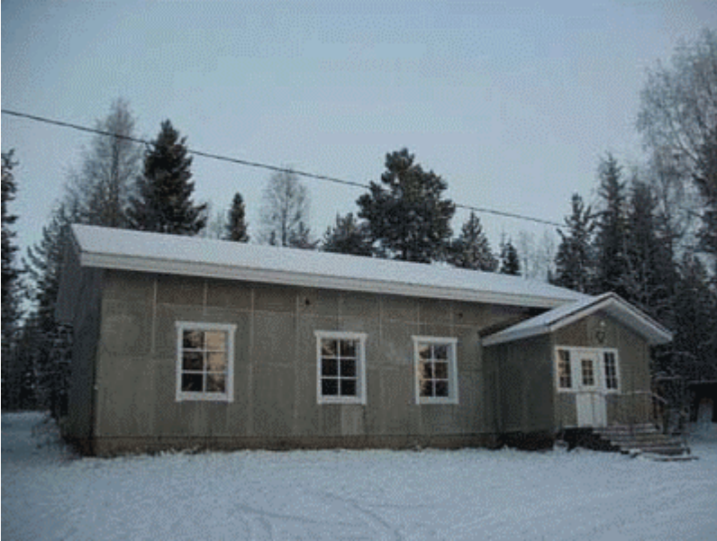
Kylätalon katto on uusittu
