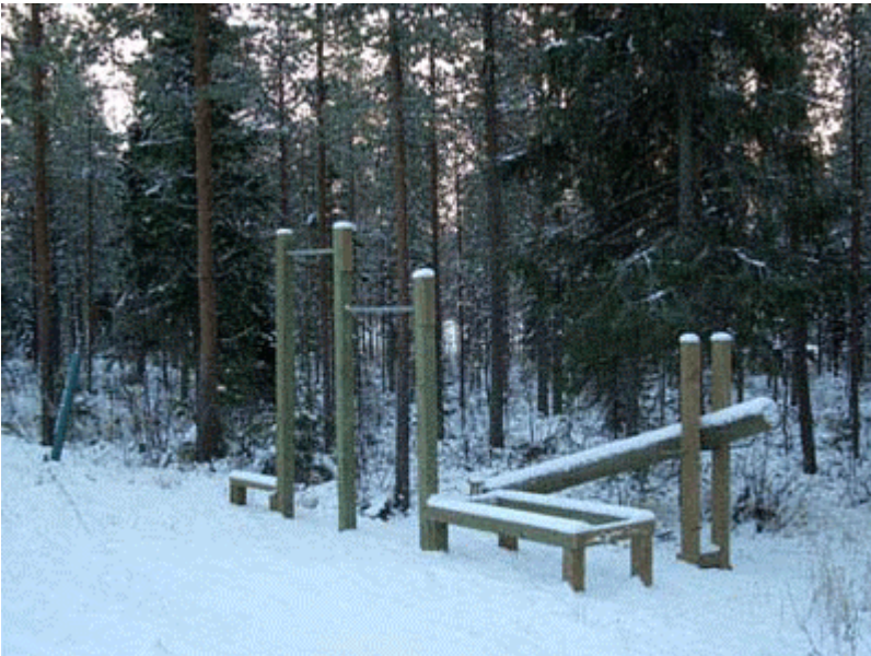
Raivaus suoritettiin ja kuntoilutelineitä rakennettiin
