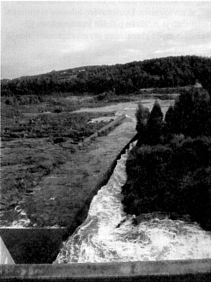
Kuva 10. Padolta alaspäin näkyvä ohijuoksutusuoma. Osa ohijuoksutettavasta vedestä ohjataan kalatien alaosaan kalatien houkutusvirtaaman lisäämiseksi.
