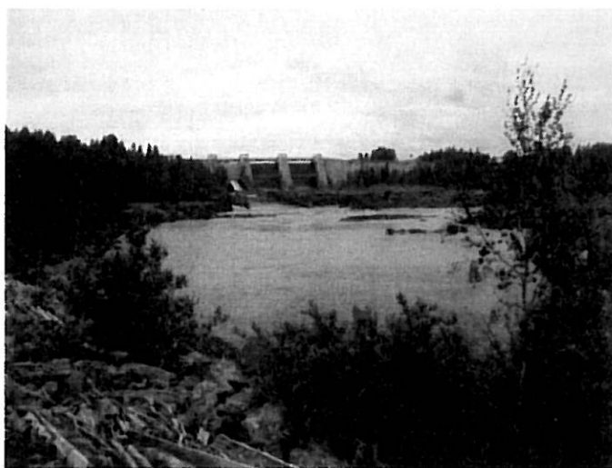
Kuva 7. Stornorrforsin voimalaitoksen tulva-aukot ja ohijuoksuoskanavan yläosa. Keskellä kalatien sisäänkäynti.
