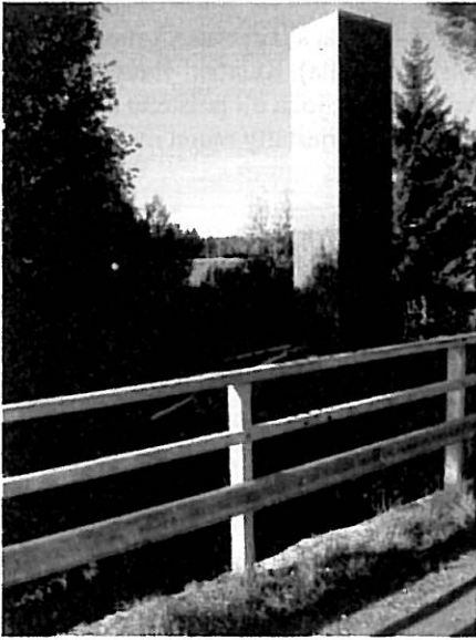
Kuva 20. Kalkitusasema viereiseltä sillalta kuvattuna.
