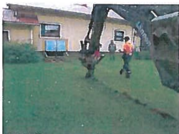
Kesäkauden 2013 kaivuita. Kaapelin vienti auraamalla/ Viitanen Oy. (Kiinteistön viimeiset 50m ei kuulu Kyläverkkoon)
