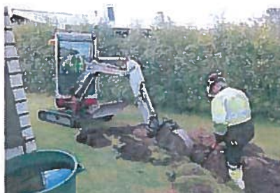
Kesäkauden 2014 kaivuita. Paavontien tonttikaivuu pikkukaivurilla/Kovalainen Oy. (Kiinteistön viimeiset 50m ei kuulu Kyläverkkoon)
