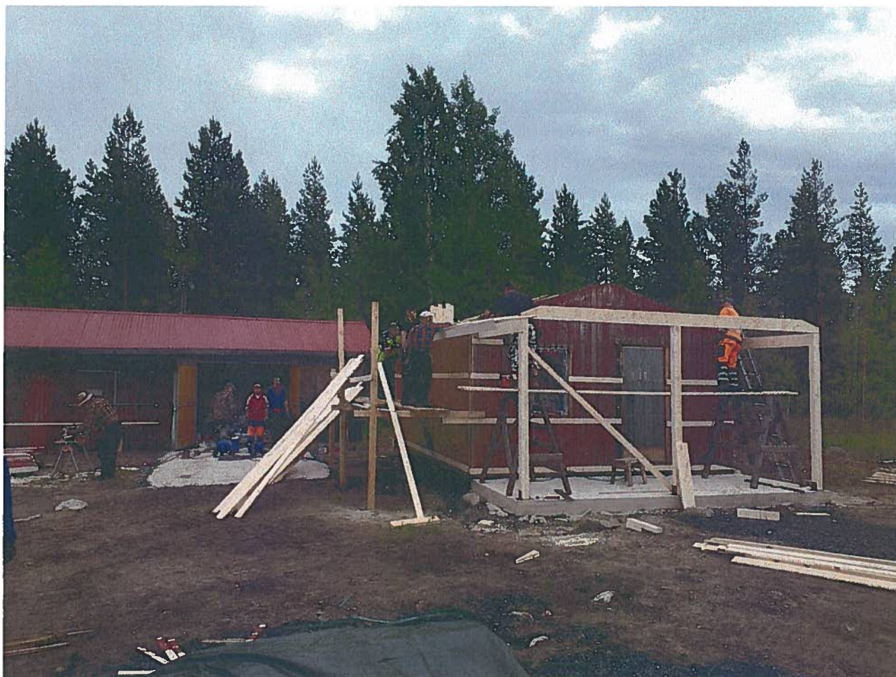
Toimistorakennus on menettänyt "hattunsa" ja alkaa saada viitteitä uudesta ulkomuodostaan.
