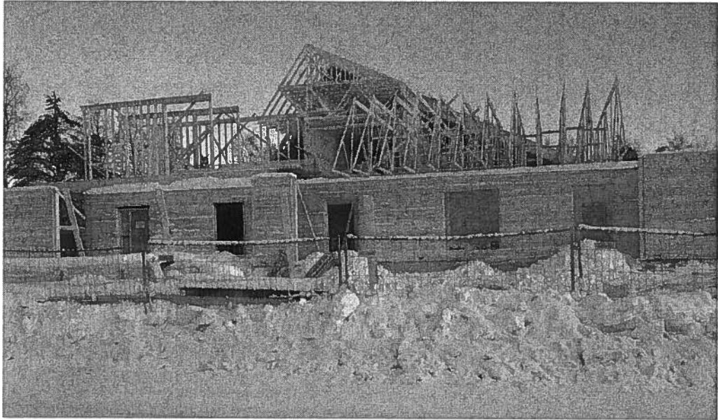
Kuva 11. Pudasjärven päiväkodin rakennusvaihe helmikuussa 2013
