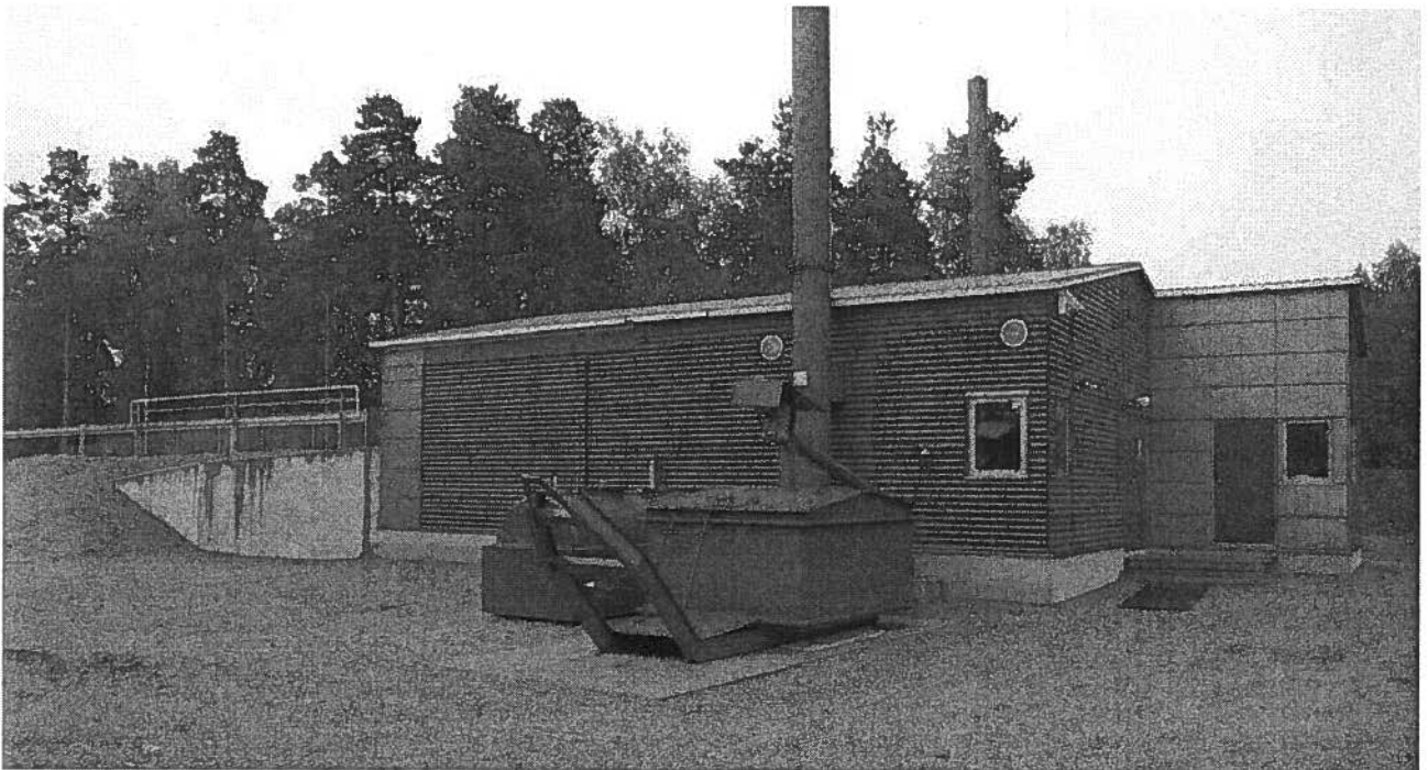
Kuva 19 Kärkölän lämpökeskus, Toimittajana Sykäke Oy, Sykäräinen
