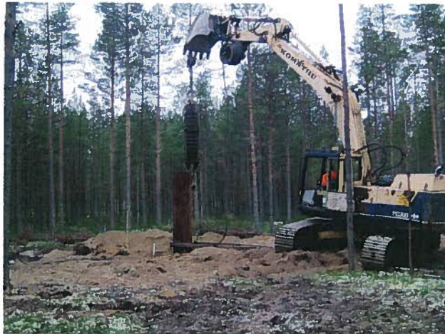
Kuva: Siiviläputkikaivon kaivaminen työpötkän avulla
