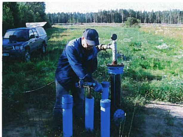
Kuva: Uusi syöttöjohto otettiin käyttöön 16.8.2010 avaamalla syöttöjohdon päässä oleva sulkuventtiili Karinkannassa
