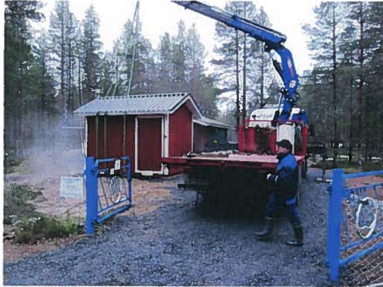
Kuva: Varavoimakonetta asennetaan paikalleen
