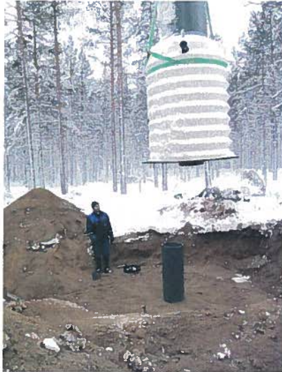
Kuva: Siiviläputkikaivon yläosaan asennetaan suojakaivoa
