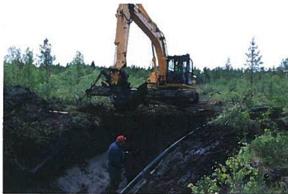
Kuva: Syöttövesijohdon asennusta
