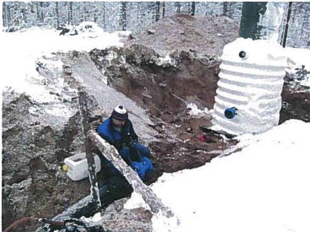
Kuva: Siiviläputkikaivon suojakaivo asennettu ilman ympärystäyttöä, paineputken asennusta valmistellaan
