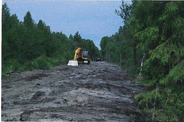
Kuva : Jälkitöitä johtolinjalla
