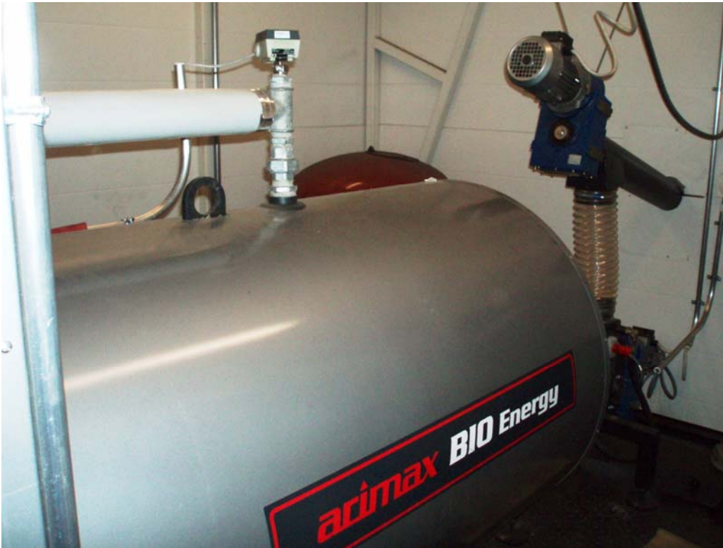
Kuva 9. Ruokohelpipelletin polttoa kokeiltiin Kuivaniemellä sijaitsevassa 500 kW:n arinakattilassa, jossa normaalisti poltetaan puupellettiä.
