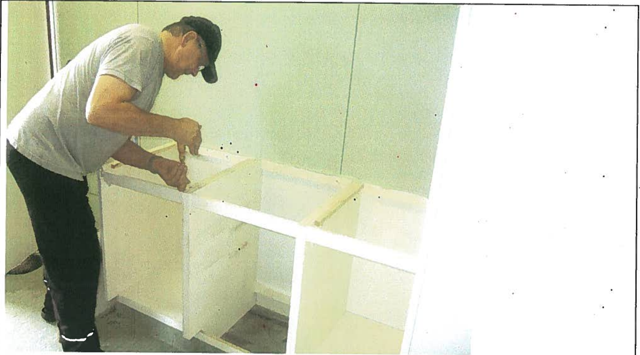
Vanhat rungot kunnostettiin
