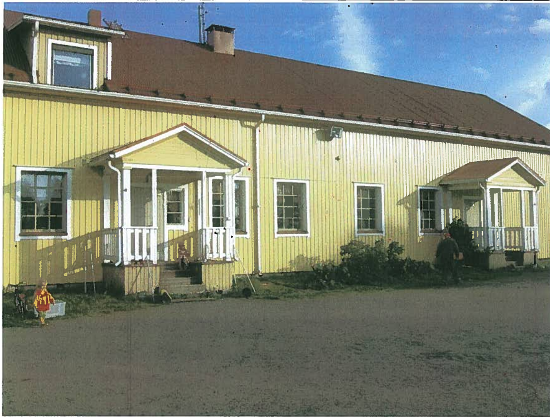
Lumiesteet asennettu, vesirännit uusittu.
