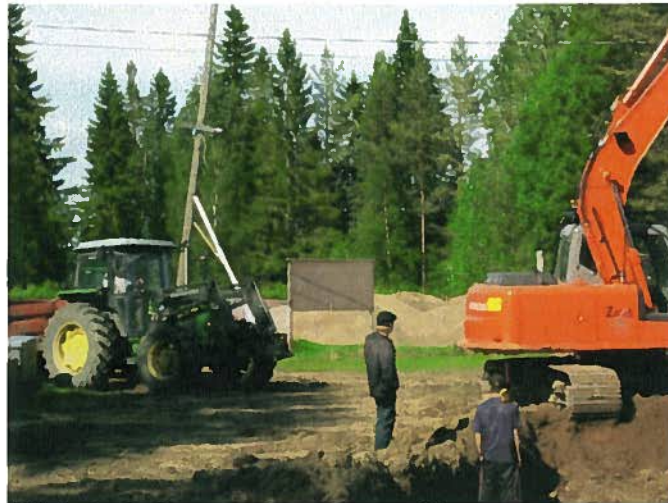
Jääkiekkokaukalon pohjan avaus 2011
