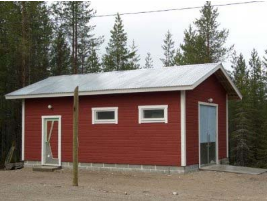
Varastorakennus rakennettiin hankkeen aikana.
