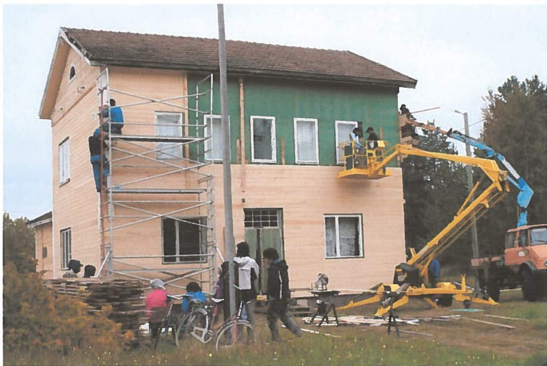
Ulkoseinälaudat naulattiin kesällä 2010. Työ valmistui syyskuussa
