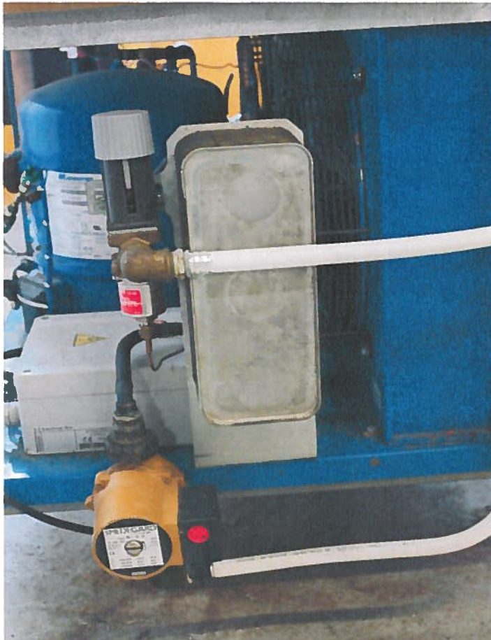
Tilakäynneillä pohdittiin maatalojen mahdollisuutta tehostaa omaa energiankäyttöään sekä kiinnostusta lisätä uusiutuvan energian osuutta. Kuvassa maidon lämmön talteenottolaite jolla voidaan maidon lämpöenergiaa käyttää käyttöveden lämmittämiseen. Kuva: Esko Viitala
